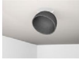
1. Unterdecke rund um die Öffnung reinigen. Bei Unterdecken mit vollflächiger Mineralwollauflage oder Brandschutzplatten die Abdeckung im Bereich der Brandschutzhaube so ausschneiden, dass die Abdeckung nach dem Einbau der Haube seitlich an diese angrenzt.
