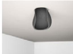
2. Öffnung für die Zuleitung des zu installierenden Downlights in der Brandschutzhaube herstellen.
